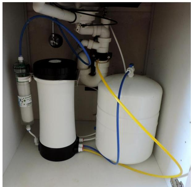
Eine Keimsperre sollte bei diesen Systemen immer verbaut werden. Damit ist sichergestellt, dass Bakterien nicht in das abgezapfte Wasser gelangen.
