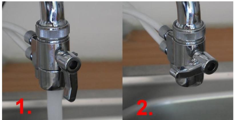
Wenn der Hebel nach unten zeigt (Bild 1.), fließt das ungefilterte Leitungswasser. Wird der Hebel quer gestellt (Bild 2.), wird die Osmoseanlage mit Wasser versorgt. Gleichzeitig fließt das produzierte Abwasser seitlich aus dem Adapter in die Spüle. Wer möchte, kann es auffangen für anderweitige Verwertung.
