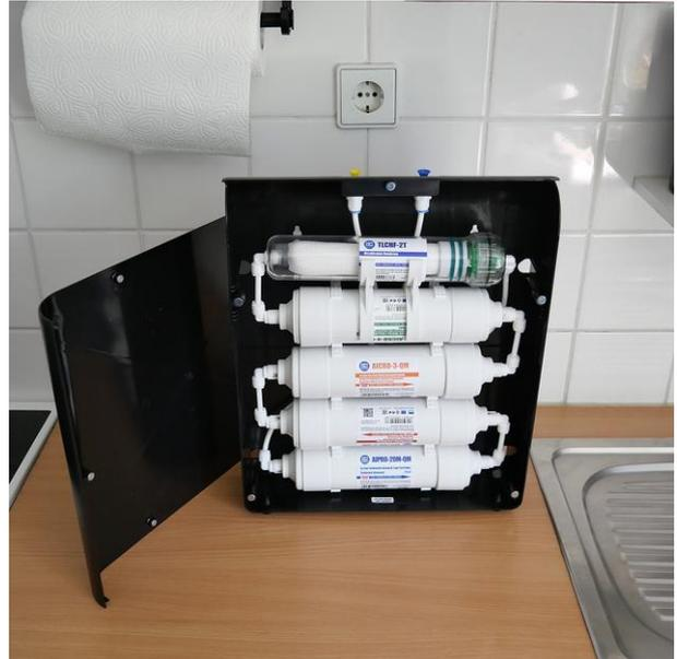
Diese Filter haben jedoch einen entscheidenden Nachteil. Die Anschlüsse für den Osmoseschlauch müssen nach jedem Filterwechsel mit Teflonband neu eingedichtet werden. Wird das nicht sorgfältig gemacht, sind sie nicht dicht.
